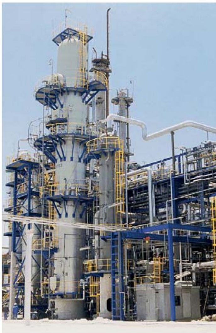
Рис. 3. Реактор оксихлорування.
