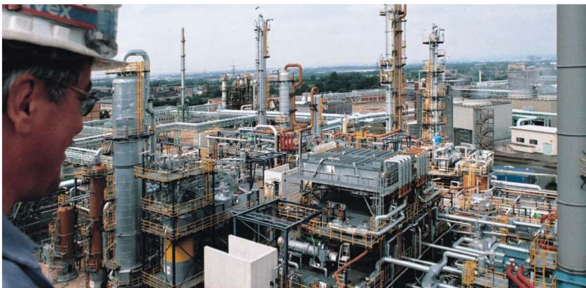
Рис. 2. Вид на одну із найбільших і найсучасніших установок з виробництва ВХ на фірмі “Vintron GmbH” під Кьолном (Німеччина). Продуктивність – 330 000 т/рік ВХ.
